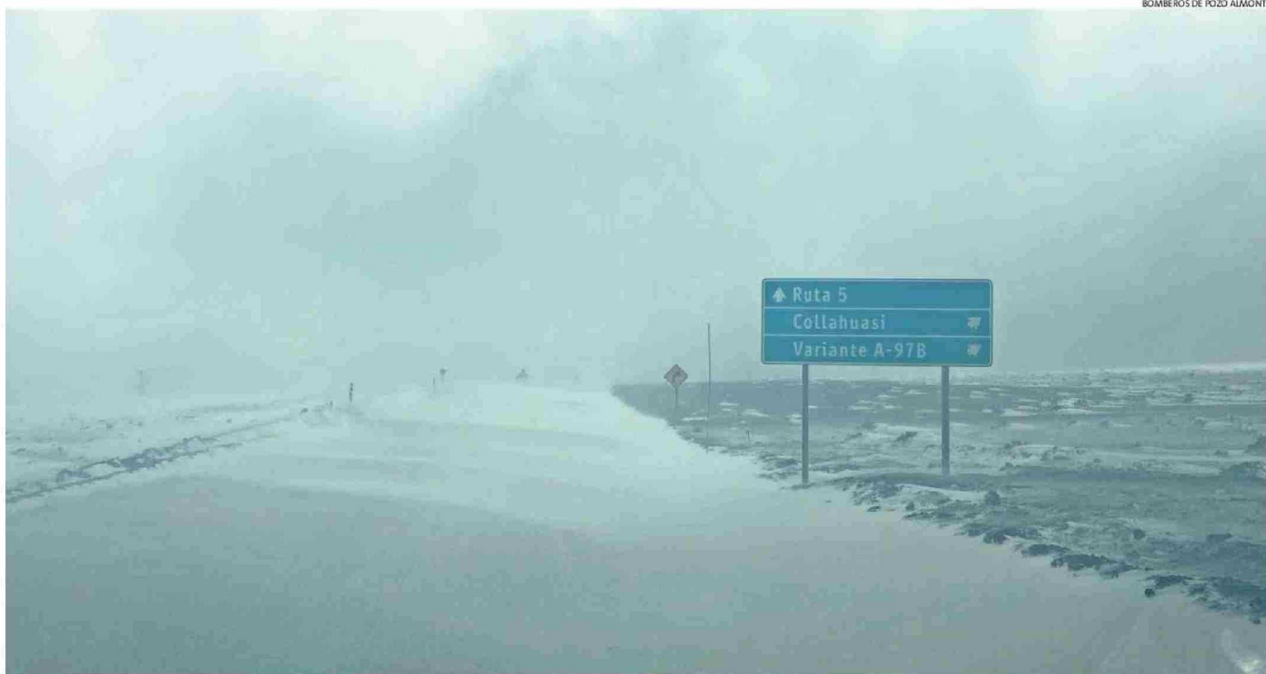
EN LA RUTA 5 HUBO UNA FUERTE NEVAZÓN. ASÍ LUCÍA LA CARRETERA AYER POR LA TARDE.
