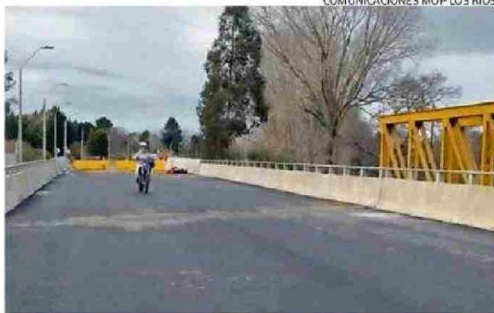
EL NUEVO PUENTE FACILITA EL ACCESO A MÁFIL POR EL SUR.
