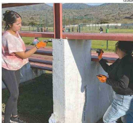
LOS TRABAJOS VOLUNTARIOS SE REALIZARON DURANTE 3 DÍAS.
