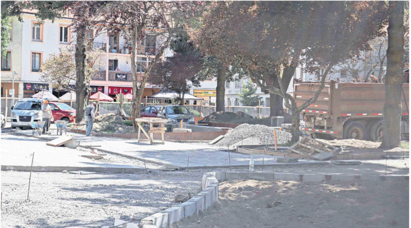
LAS OBRAS QUE DEBÍAN HABER FINALIZADO DURANTE ESTOS DÍAS, PERO QUE SE EXTENDIERON POR 71 DÍAS POR LENTITUD DE LA EMPRESA CONTRATISTA, PODRÍAN ASEGURAR MEJORES COSAS EN SEGURIDAD.
