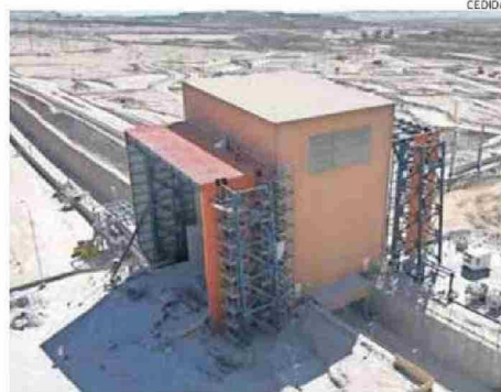
EL CHANCADOR DE DMH, MINA UBICADA A 10 KILÓMETROS DE CALAMA.
