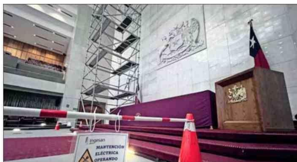
Un cono y un mensaje advirtiéndolo de los trabajos en la simbólica dependencia del Congreso, en Valparaíso, regulan el paso.
