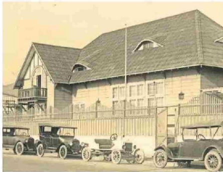
VIVIENDA DATA DE 1921, OBRA DE HOMERO LOIS FRAGA.
