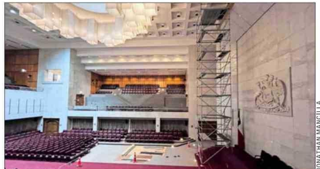
Las butacas lucen acopiadas en un extremo del Salón de Honor, para facilitar la colocación de un andamio para hacer reparaciones.
