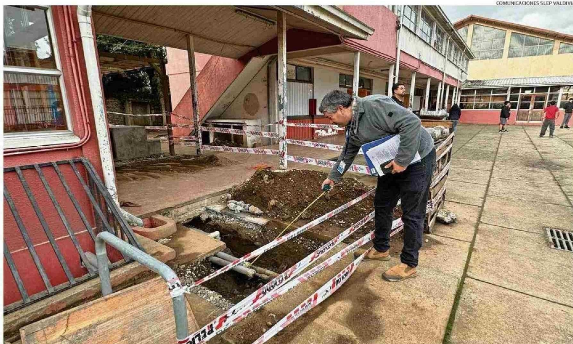
COMUNICACIONES SLEP VALDIVIA
