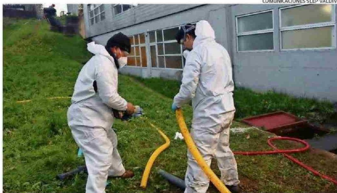
LA INTERVENCIÓN PARA ABORDAR PROYECTOS MENORES ES UNA DE LAS PRIORIDADES PARA EL SLEP VALDIVIA.
