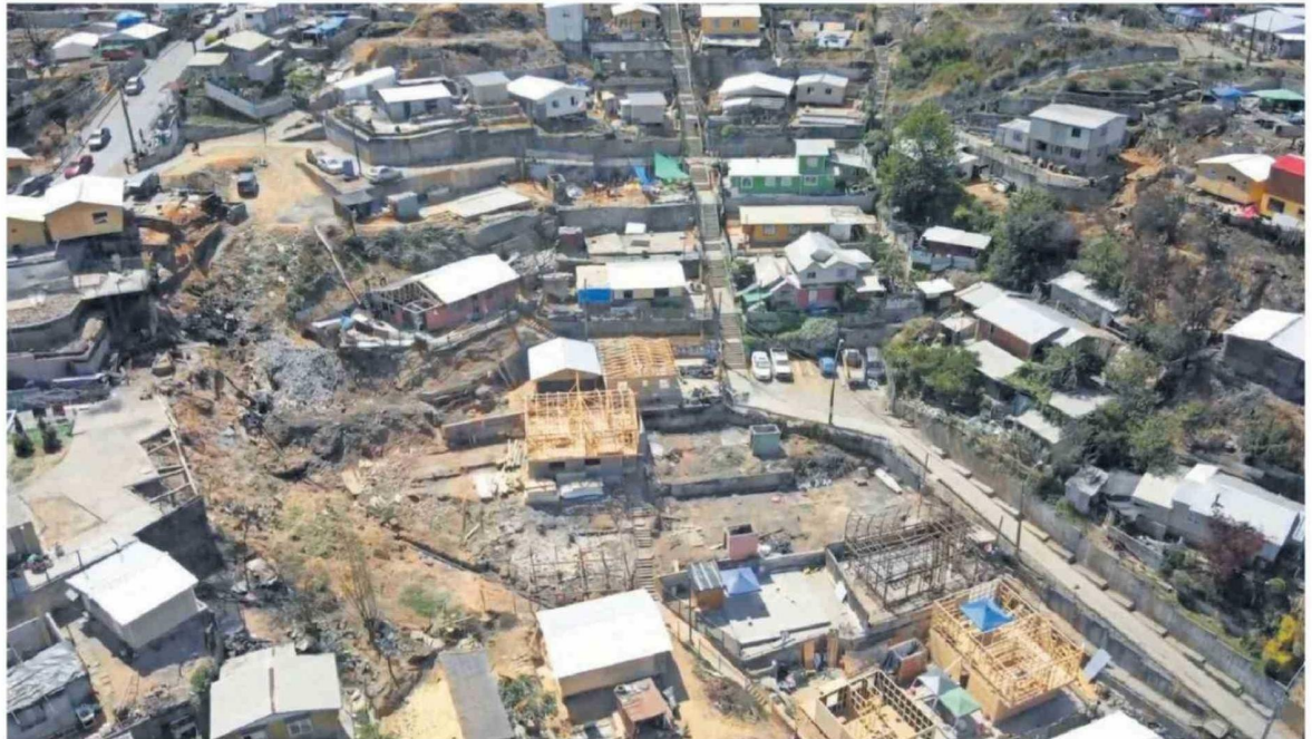
La presencia de quebradas activas, suelos con baja permeabilidad y pendientes pronunciadas son parte de los resultados que arrojó el análisis técnico en la zona.
