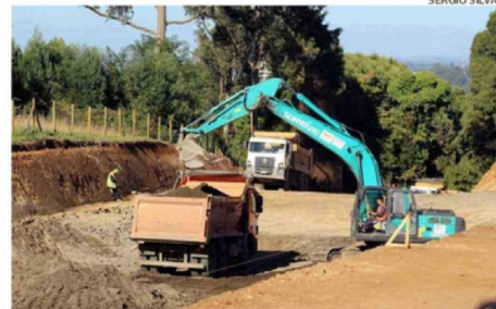
LA EMPRESA YA COMENZÓ A REALIZAR EXCAVACIONES EN LA VÍA.
