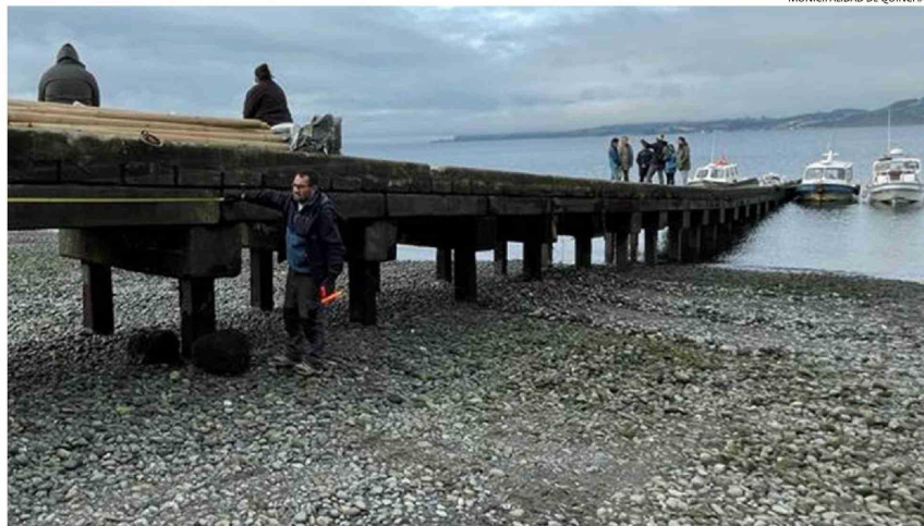
LA RAMPA DE ALAO ES UN PROYECTO QUE SE ESTÁ ANALIZANDO.
