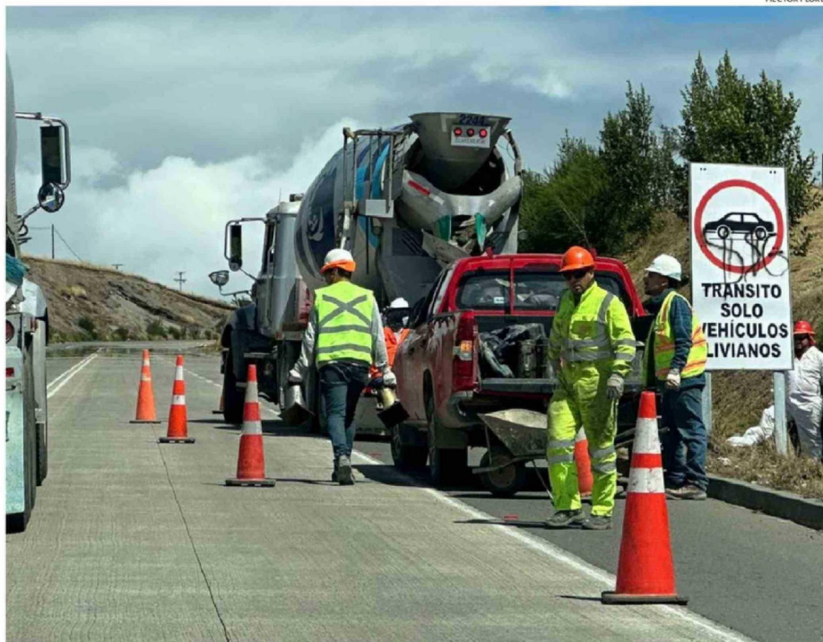
LA EMPRESA SICOMAC ESTÁ TRABAJANDO EN EL TRAZADO PARA CUMPLIR EL COMPROMISO DE ABRIR EL TRÁNSITO EN MARZO.
