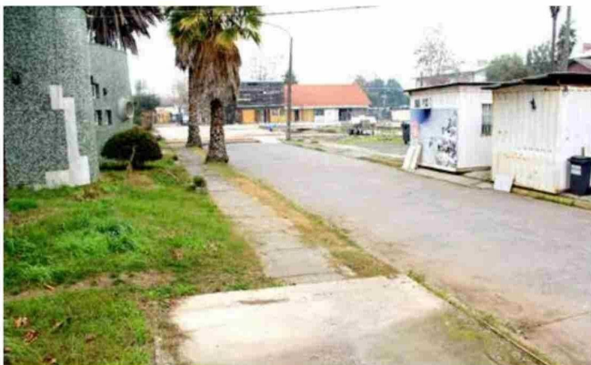
Reapertura de calle Membrillar, es el primer paso para construir el moderno Cesfam, anunciado por el alcalde George Bordachar.
