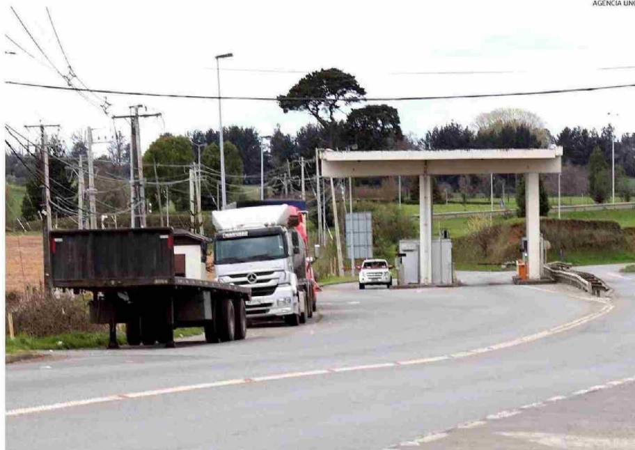
LOS TRABAJOS COMENZARÁN EN OCTUBRE PRÓXIMO, PARTIENDO DESDE EL PÓRTICO EN LA RUTA 5 HASTA LA CALLE BULNES.
