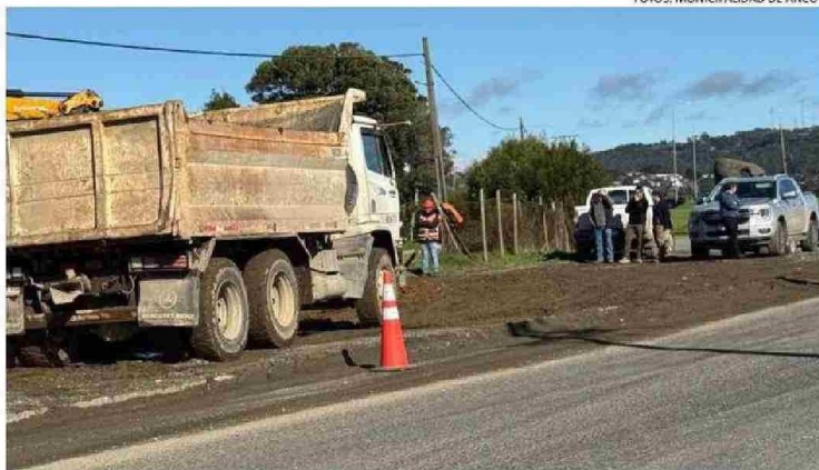
AYER COMENZARON LAS OBRAS EN LA PANAMERICANA EN LA COMUNA DE ANCUD.
