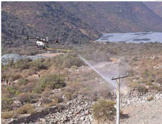
ESTE TIPO DE POSTES DE DISTRIBUCIÓN FUERON LOS BENEFICIADOS CON LA NOVEDOSA LIMPIEZA.
