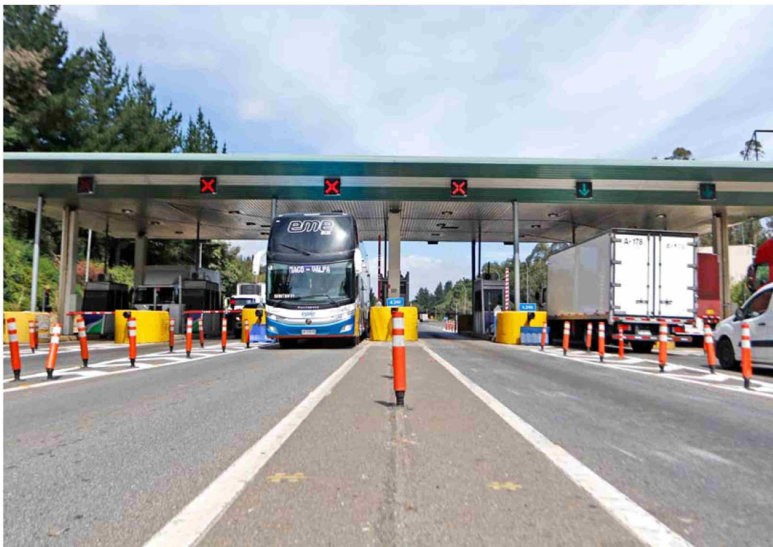
Una de las primeras intervenciones de Sacyr será mejorar la seguridad vial del acceso norte al Gran Concepción.
