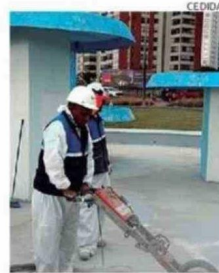
TRABAJOS EN PILETA SECTOR SUR.
