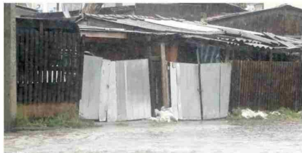
El peligro de anegamiento de viviendas, era evidente producto de la intensidad de las precipitaciones.
