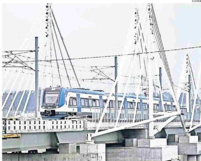
DESDE AYER EL BIOTREN COMENZÓ A REALIZAR SUS SERVICIOS HACIA CORONEL POR EL NUEVO PUENTE.
