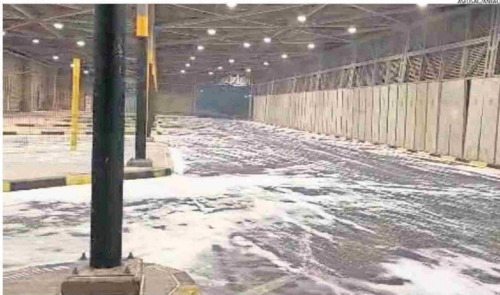
ASÍ LUCE UNO DE LOS ESPACIOS AL INTERIOR DEL COMPLEJO CHUNGARÁ, DONDE SE REVISAN A LOS BUSES Y CAMIONES A 4.680 M.S.N.M.
