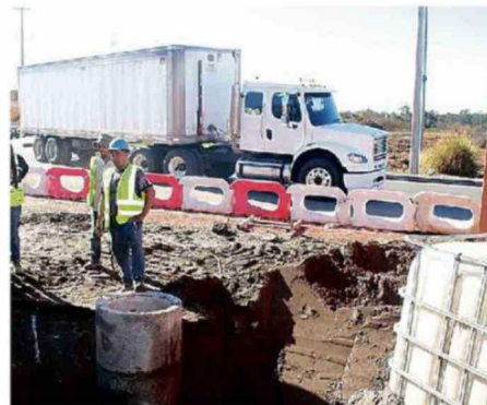
LAS OBRAS EN CALLE BROECKMAN ALCANZAN UN 67% DE AVANCE.
