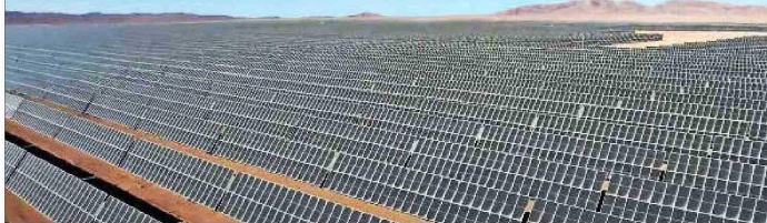
Planta Solar Tamaya, de Engie, en Tocopilla.
