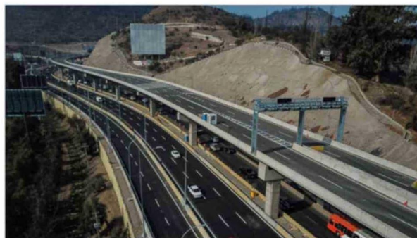
El Viaducto El Salto es un lugar olvidado en una frontera comunal que requiere intervención para mejorar su seguridad.
