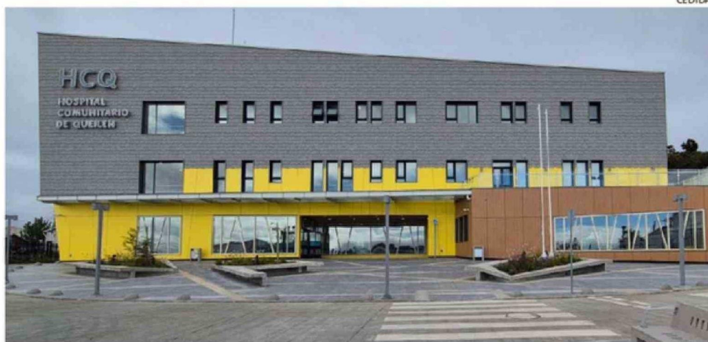
TRAS 11 AÑOS DEL INCENDIO DEL ANTIGUO EDIFICIO, LA COMUNA CUENTA CON NUEVO HOSPITAL.
