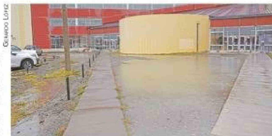
En el recinto de la Umag se formaron algunas "piscinas".
