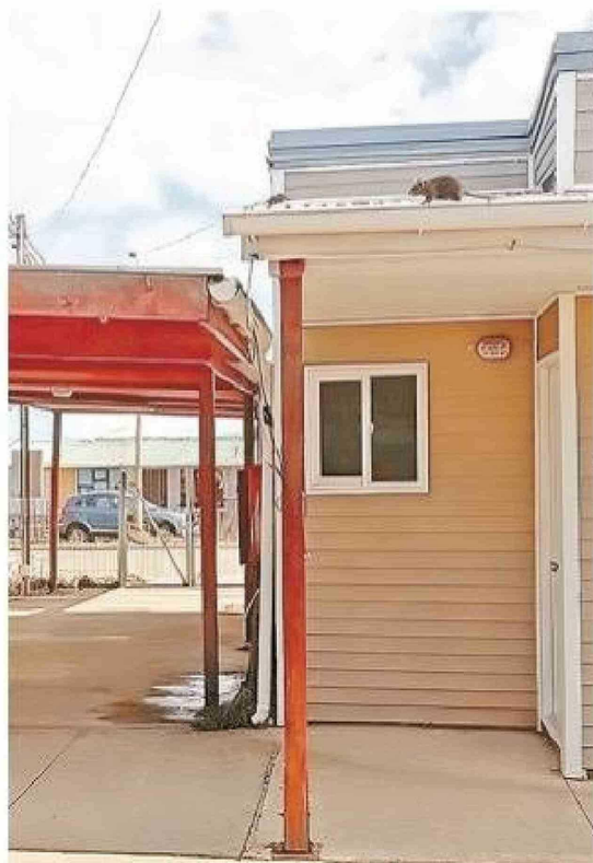
"El alcantarillado es precisamente para evitar la presencia de roedores y otras especies dañinas", resumió una fuente de Aguas Magallanes.
