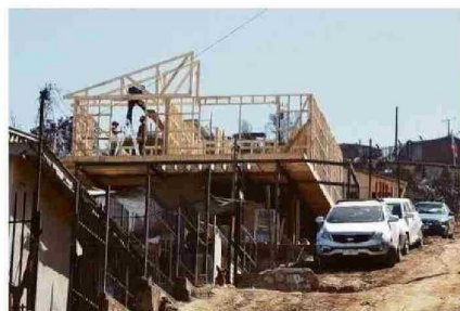
MUCHOS AFECTADOS HAN OPTADO POR LA AUTOCONSTRUCCIÓN.
