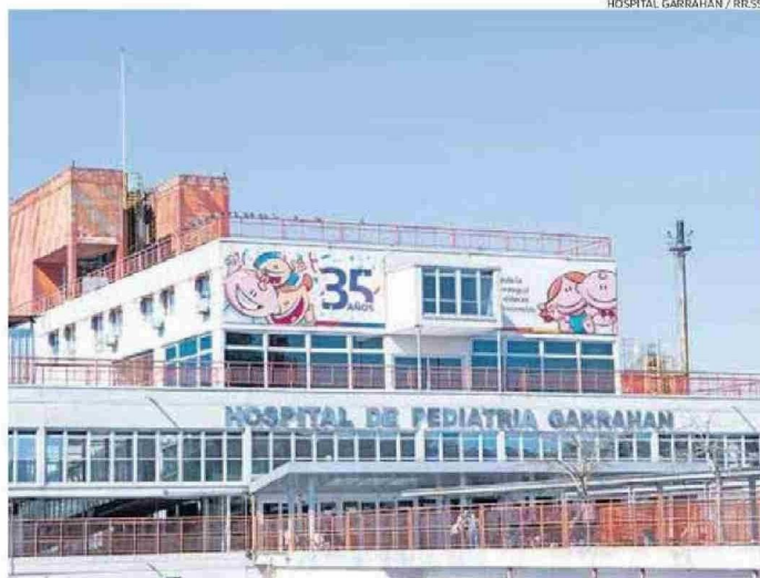
EL HOSPITAL FUE FUNDADO EN 1987 COMO CENTRO PEDIÁTRICO DE ALTA COMPLEJIDAD.
