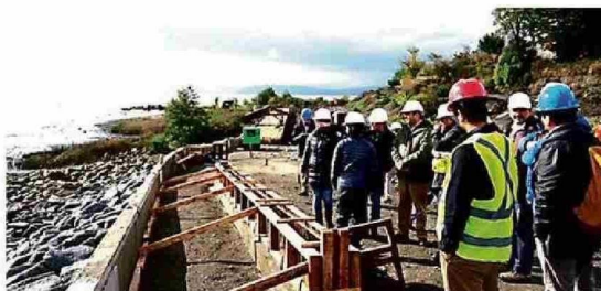
Visita inspectiva a obra de borde costero en sector Iansa.
