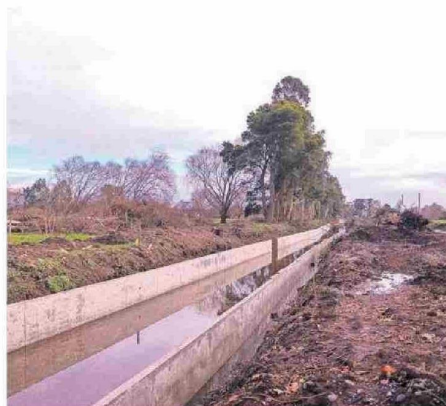
Un total de 142 regantes podrán ser beneficiados con la obra.
