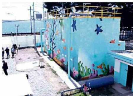
Estanques de tormenta de Puerto Varas
