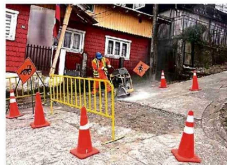
Desde 2021 renovamos más de 76 mil metros de redes en Puerto Montt
