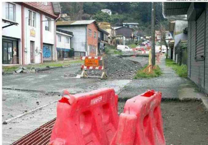
DESDE EL MUNICIPIO ASEGURARON QUE HACE UN MES DEBIERON DETENER LOS TRABAJOS EN CALLE ECUADOR.
