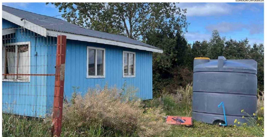
UNO DE LOS ESTANQUES ESTÁ INSTALADO EN LA SEDE DEL COMITÉ DE AGUA POTABLE RURAL DE CURANUÉ.
