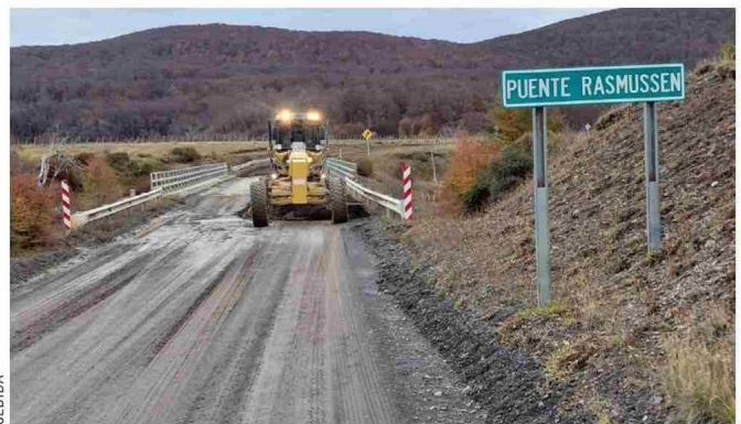
Ruta Y-85 Puente Rasmussen, Km 159.
