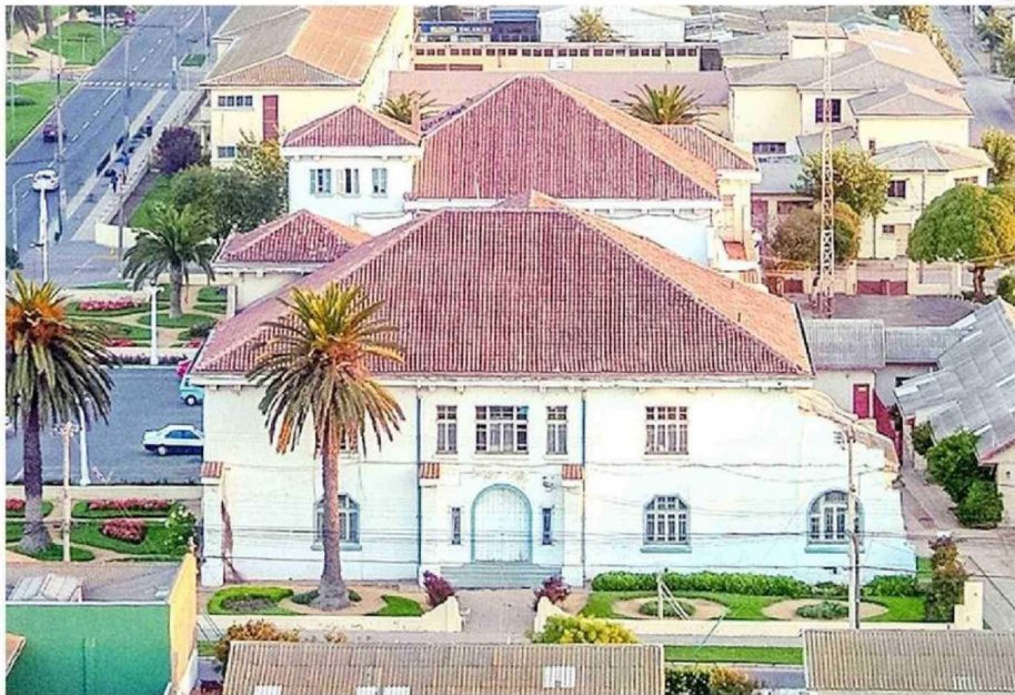
EDIFICIO MUNICIPAL DE SAN ANTONIO, CUYA REMODELACIÓN ESTÁ EN EVALUACIÓN.
