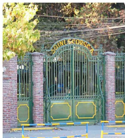
Fachada del Colegio Saint George's, donde se originó este caso.
