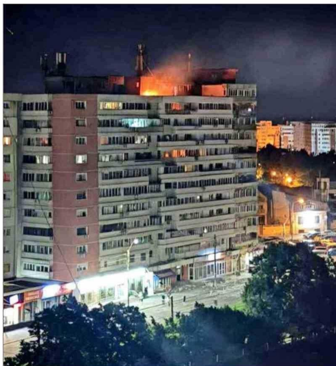
EL IMPACTO del dron provocó un incendio en un edificio residencial en Galati, una ciudad rumana cercana a la frontera con Ucrania.
