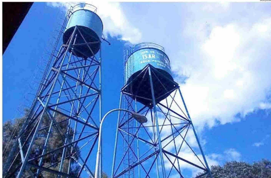
ACTUALMENTE, SE HAN GESTIONADO RECURSOS PARA ABASTECER A ESTOS SECTORES DE AGUA POTABLE.
