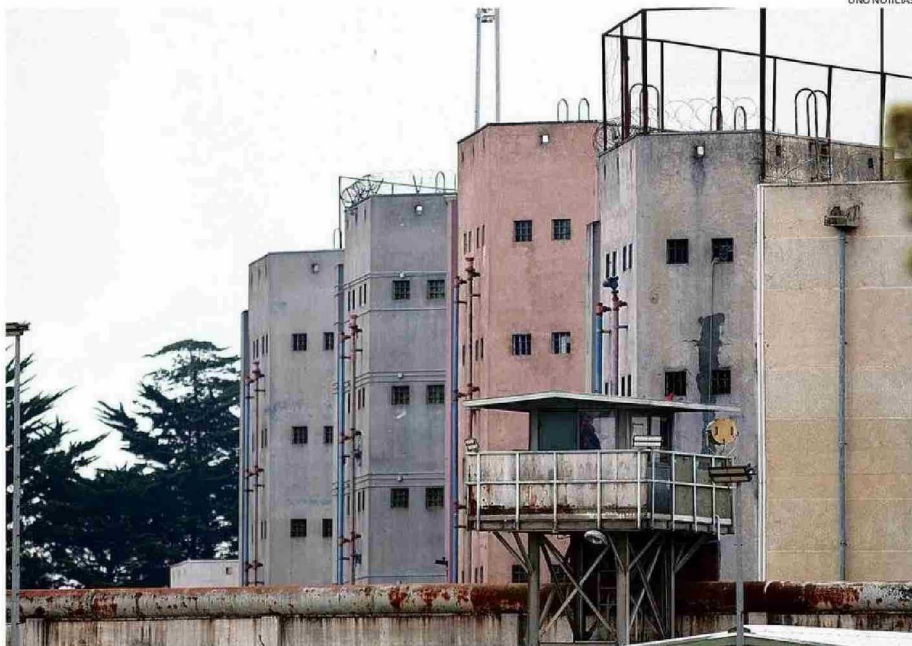
SE ESTÁ A LA ESPERA DE LA TOMA DE RAZÓN DE CONTRALORÍA PARA QUE COMIENCE LA INSTALACIÓN DE INHIBIDORES EN VALPARAÍSO.
