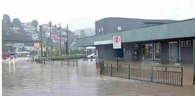
El Cesfam Alameda resistió las fuertes lluvias, pese a que el desborde del canal "El Carbón" repletó el exterior con aguas que llegaron a gran altura.
