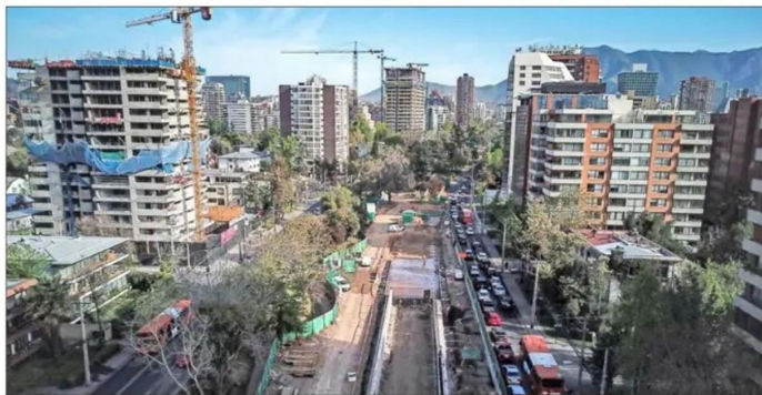
PROYECTO.— En 2018 se iniciaron las intervenciones en Vitacura para la construcción de AVO, mientras que este año comenzó el desarrollo de las obras en Las Condes.
