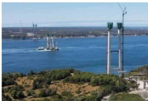
VISTA DE LAS TRES PILAS DEL PUENTE EN EL CANAL DE CHACAO.
