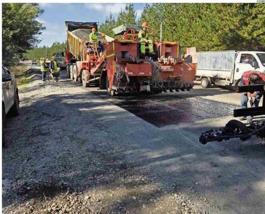
OBRAS DE LA CONSERVACIÓN DE RUTA N85 EN PEMUCO REGISTRAN 99% DE AVANCE. ALCALDE VALORÓ INICIATIVA POR LO VIAL Y EMPLEOS.
