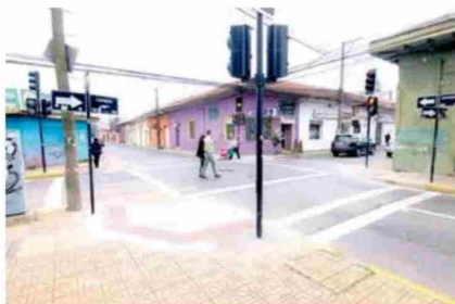
Vereda de Carmen, entre Villota y Argomedo está habilitada para personas en situación de discapacidad.
