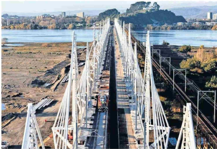
Durante dos semanas se hicieron pruebas y las conexiones necesarias del nuevo puente de 1,9 kilómetros de largo.
