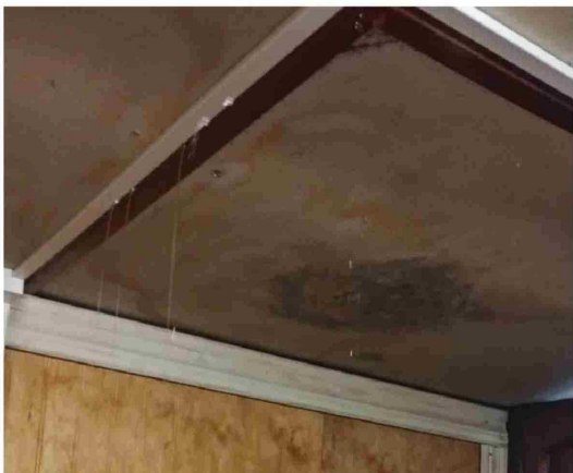
EL PROYECTO DE REMODELACIÓN de Flores I y II permanece estancado, a la espera de que un nuevo plan de acción sea aprobado.
