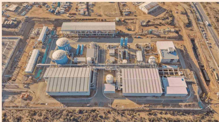
Planta Aguas Pacífico.
