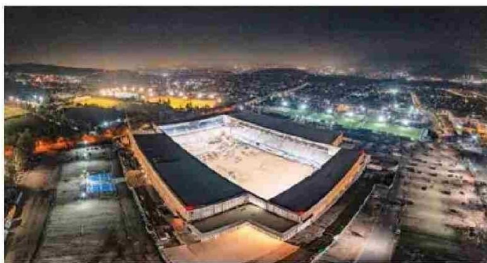
Para la autogeneración de energía se instalaron 400 paneles solares en el techo de la cubierta de la construcción.
